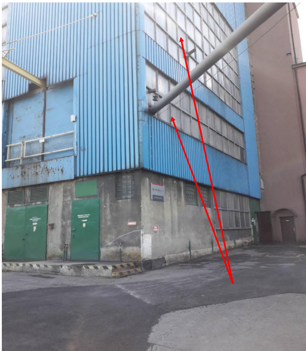
Fot. nr 2. Istniejące przeszklenie ściennie traktowane jako powierzchnia odciężeniowa w ścianie zachodniej w strefie pożarowej SP1 PM – kotłowni z kotłem OR-32/14 o mocy 25 MW.
