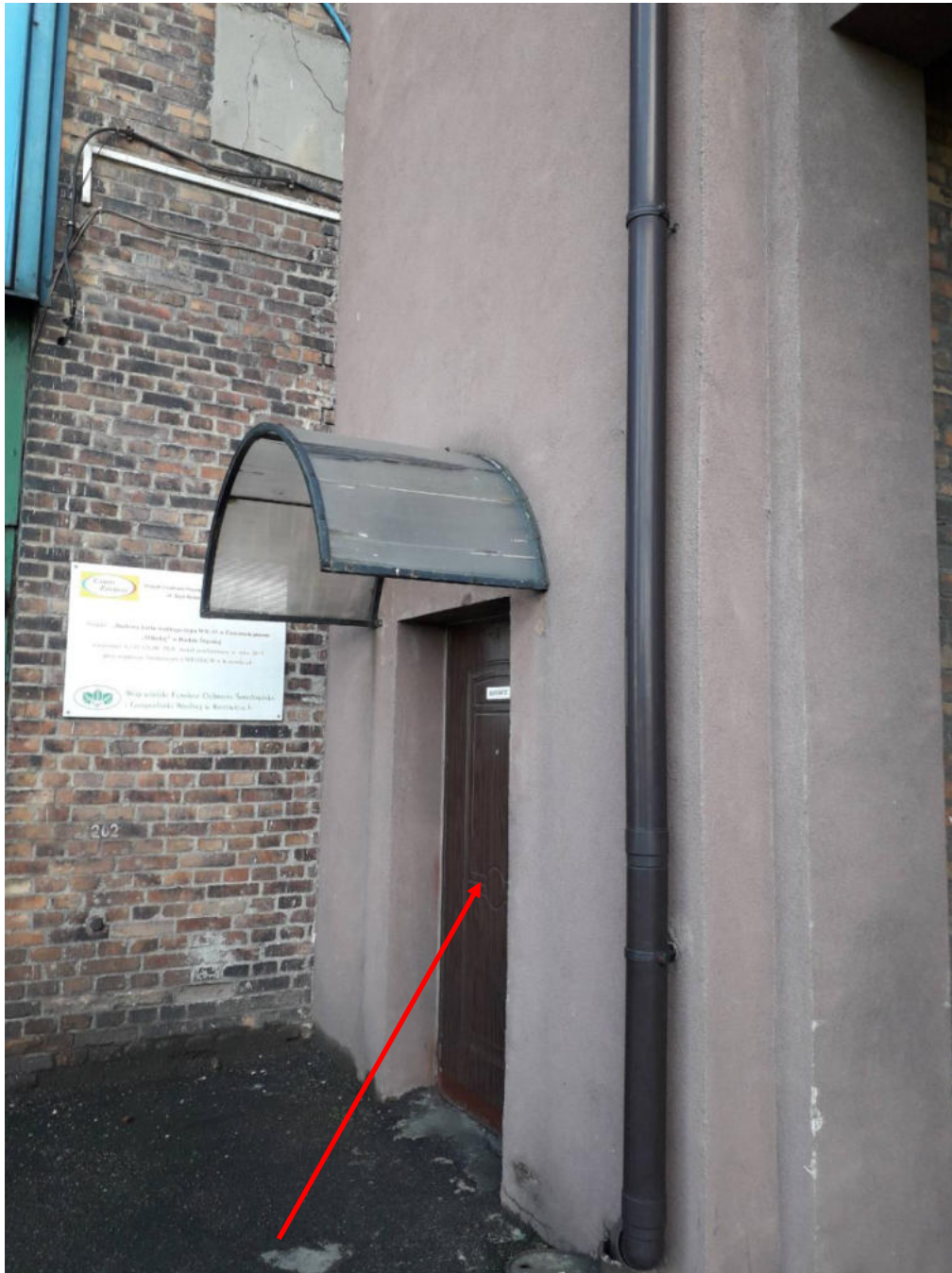
Fot. nr 5. Drzwi ewakuacyjne prowadzące na zewnątrz z istniejącej głównej klatki schodowej stanowiącej pionową drogę ewakuacyjną ze strefy pożarowej SP1 PM i SP2 PM .
