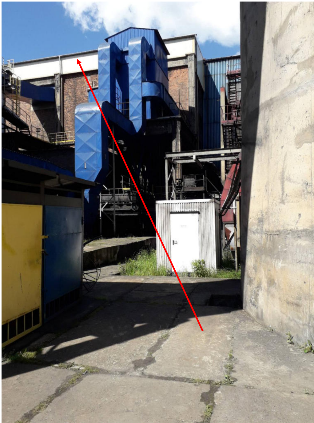
Fot. nr 4. Istniejący „dach lekki” jako powierzchnia odciążeniowa w strefie pożarowej SP2 PM – kotłowni z kotłami OR-50-N/12 o mocy 39,60 MW oraz WR-15-N/1 o mocy 15 MW.
